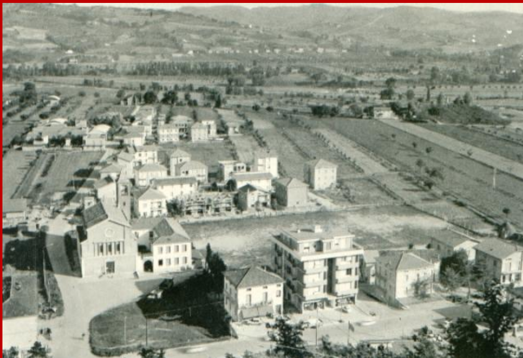
1970 Via Giacomo Puccini alle spalle della chiesa vede altre abitazioni in costruzione
